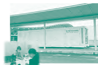
関西国際空港にロボットPCR検査システムを設置し検査サービスを実施中（コンテナ内に検査システムをコンパクトに配置）
